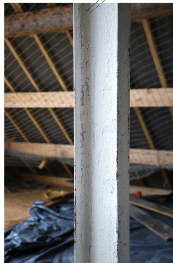
Les profilés métalliques ont été remis en état et reposés sur le bâtiment dans les cages d'escalier.
