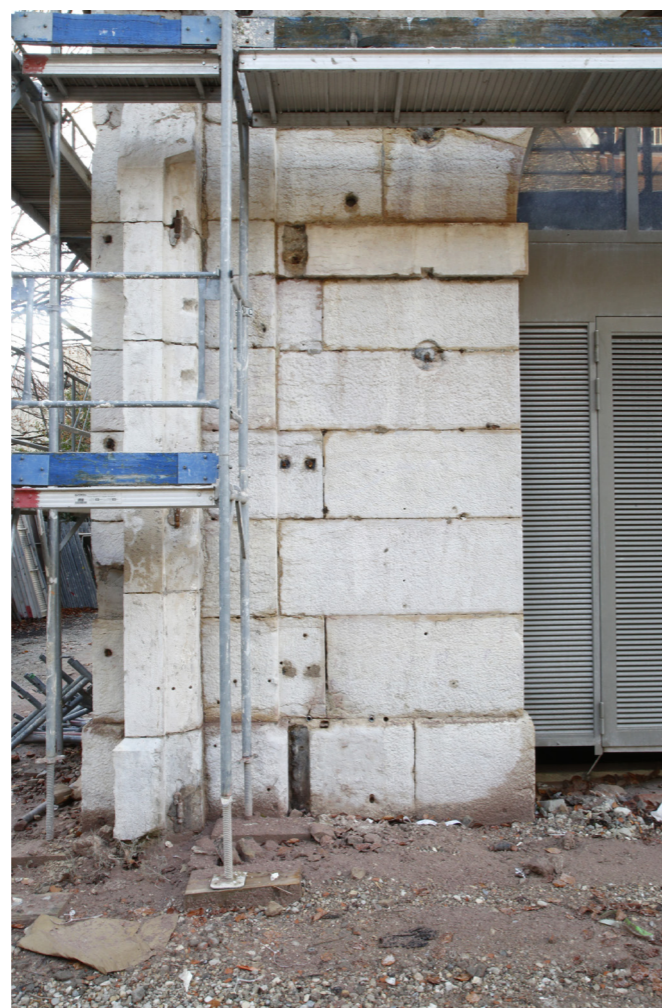
Grâce à l'aérogommage des façades, on retrouve les teintes d'origine des pierres de Chailluz, de Comblanchien et de Corton mélangées. A l'époque, tout était local !
