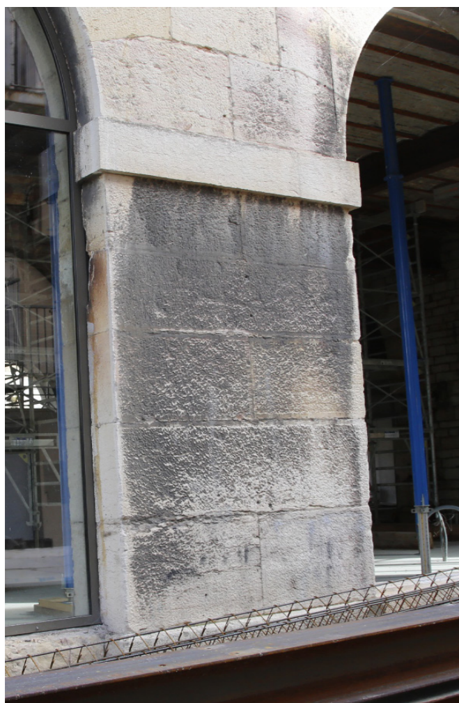
Grâce à l'aérogommage des façades, on retrouve les teintes d'origine des pierres de Chailluz, de Comblanchien et de Corton mélangées. A l'époque, tout était local !
