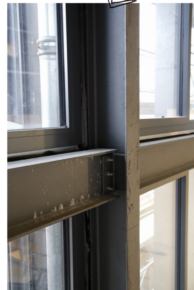
Les profilés métalliques ont été remis en état et reposés sur le bâtiment dans les cages d'escalier.
